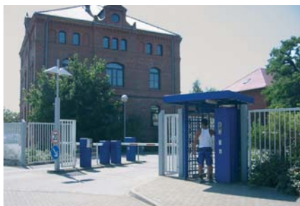
Contrôle d'accès des personnes et véhicules
